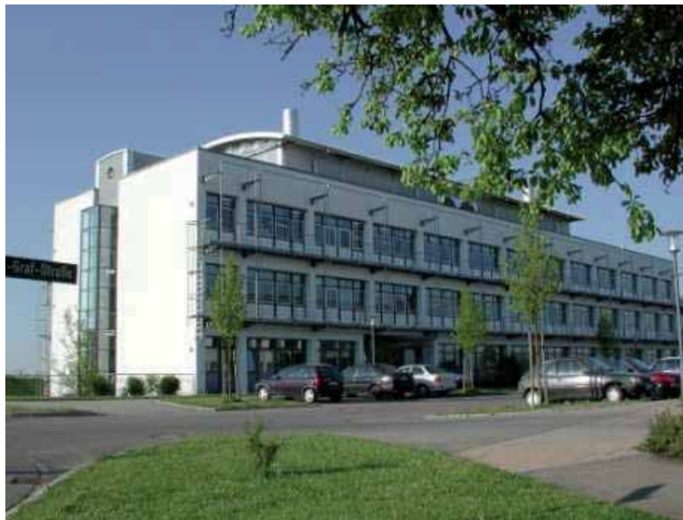
1. Bauabschnitt des Chemischen und Veterinäruntersuchungsamtes Sigmaringen
